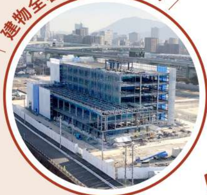
▲鉄骨部分の完成(2021.1.31時点)
