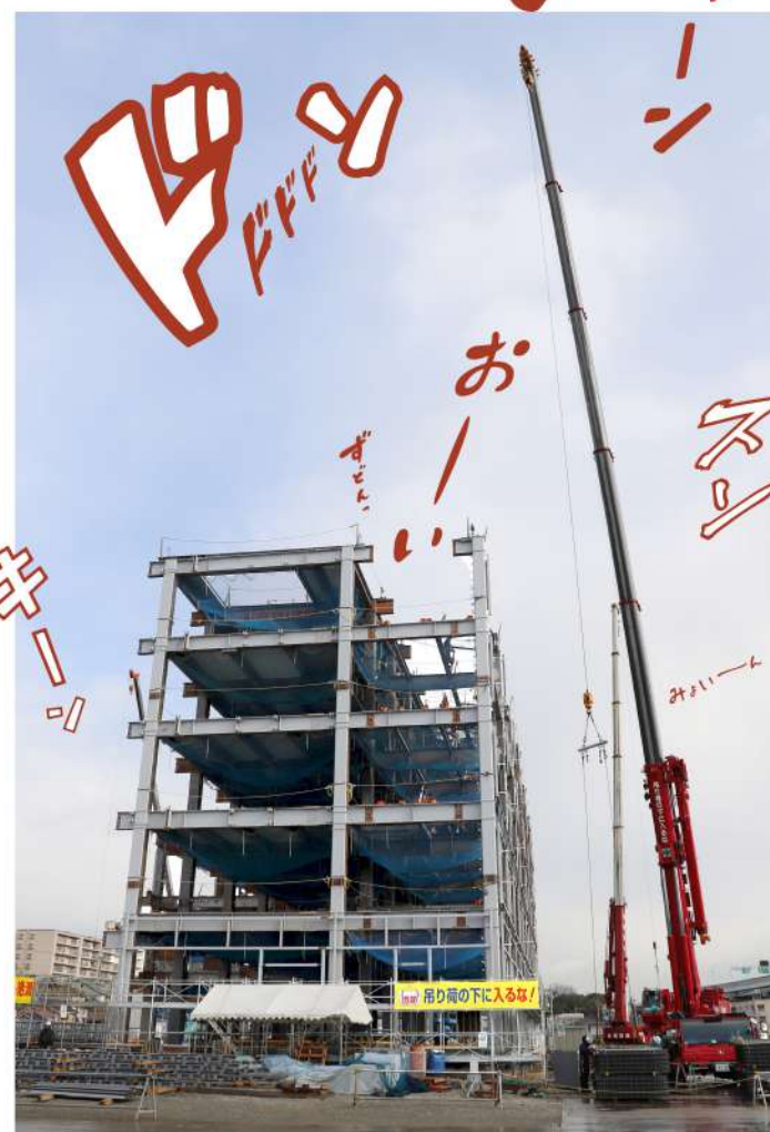
▲クレーン車での鉄骨組み上げ風景(2021.1.12時点)
