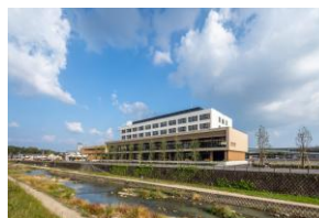
新病院外観 (2021 年 11 月新築移転)
